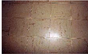
Dalles de sol
