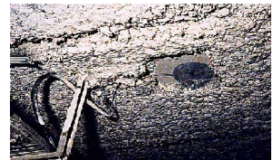
Flocage de plafond
